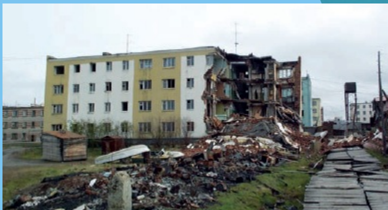
Неравномерное оседание и разрушение угла дома, в связи с таянием вечной мерзлоты. Черского, Сибирь. (Фото: В. Романовский).
