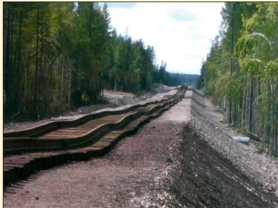
Деформация железнодорожного полотна, вызванная мерзлотным пучением
