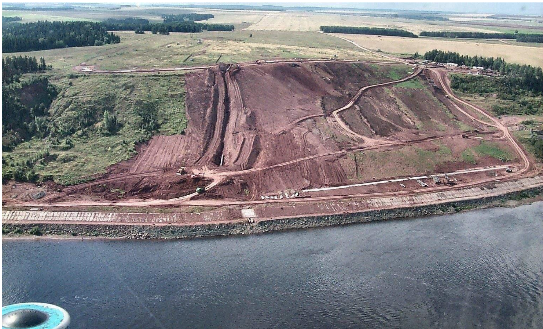
Вид оползневого склона с Восточной стороны
